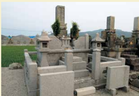
地震崩壊墓。改修、補修、清掃し仕上完了。10日間位。
